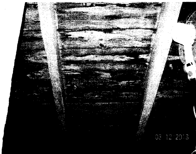
Fot.16. Nalot z pleśni na powierzchni poszycia dachowego z desek.
