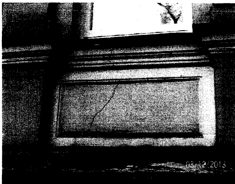
Fot.4. Pęknięcie na powierzchni ryzalitu na elewacji wschodniej.
