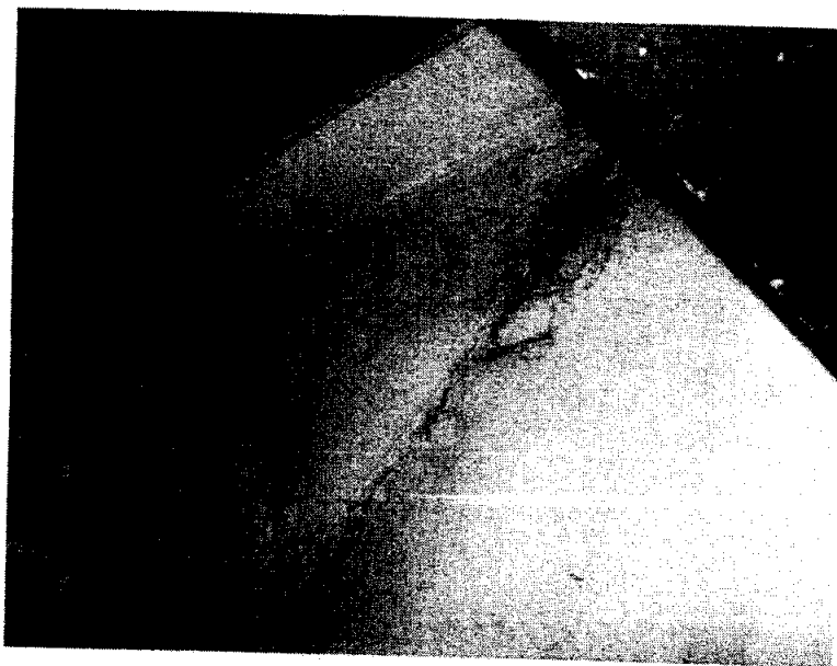
Fot.10. Pęknięta ściana przy drzwiach wejściowych na strych.
