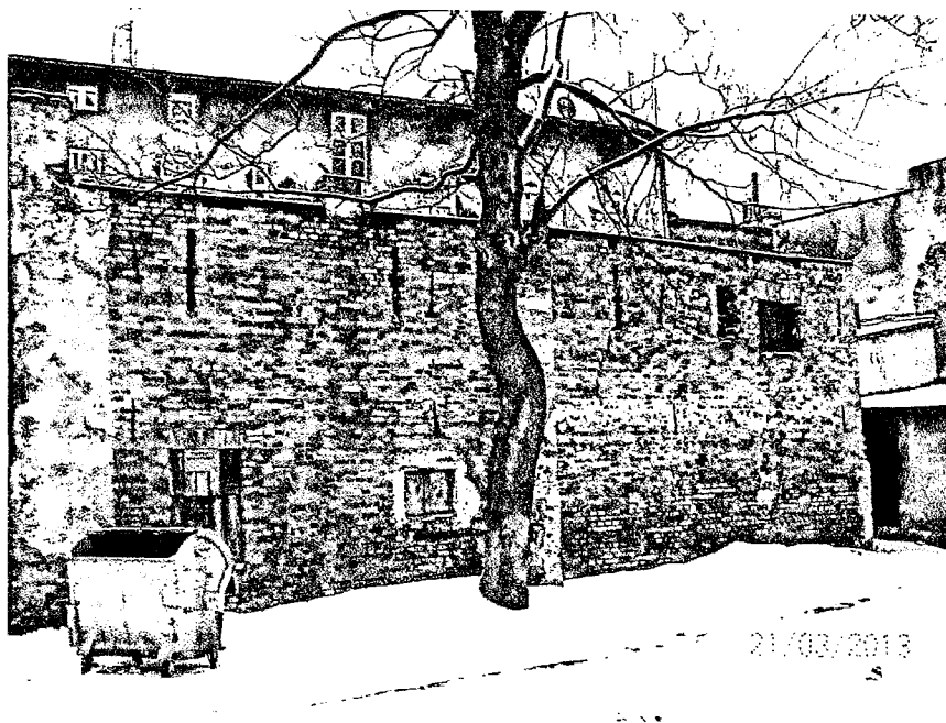
Fot. 2. Elewacja tylna (południowa) budynku.
