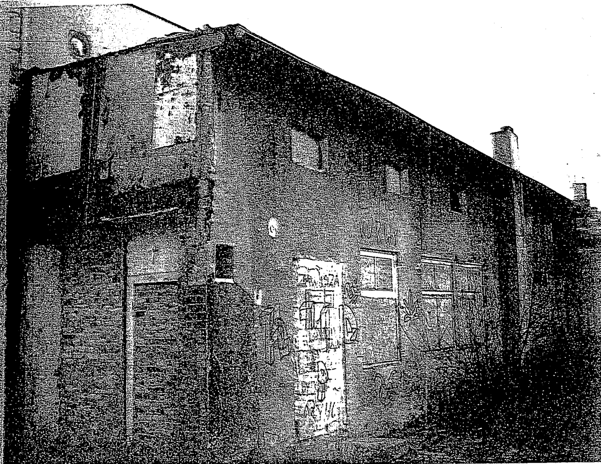
widok od strony podwórza
