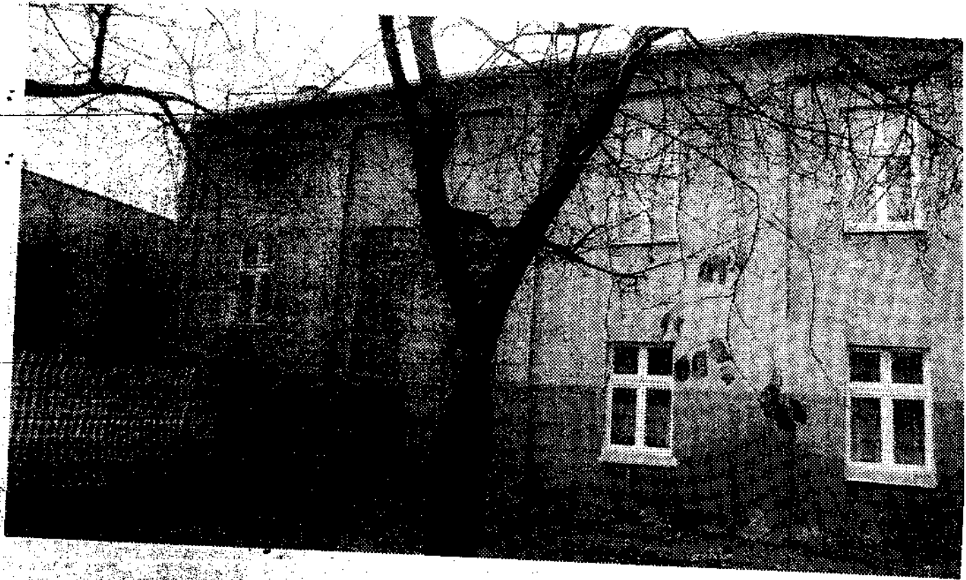
UL. Mazowiecka 24 Elewacja północna - od podwórza
