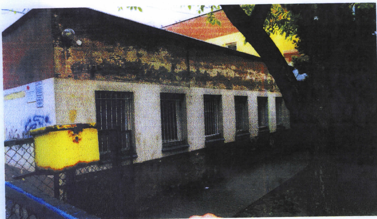
Fot . 6. Ściana G. Fot. Bogdan Rudzionic
