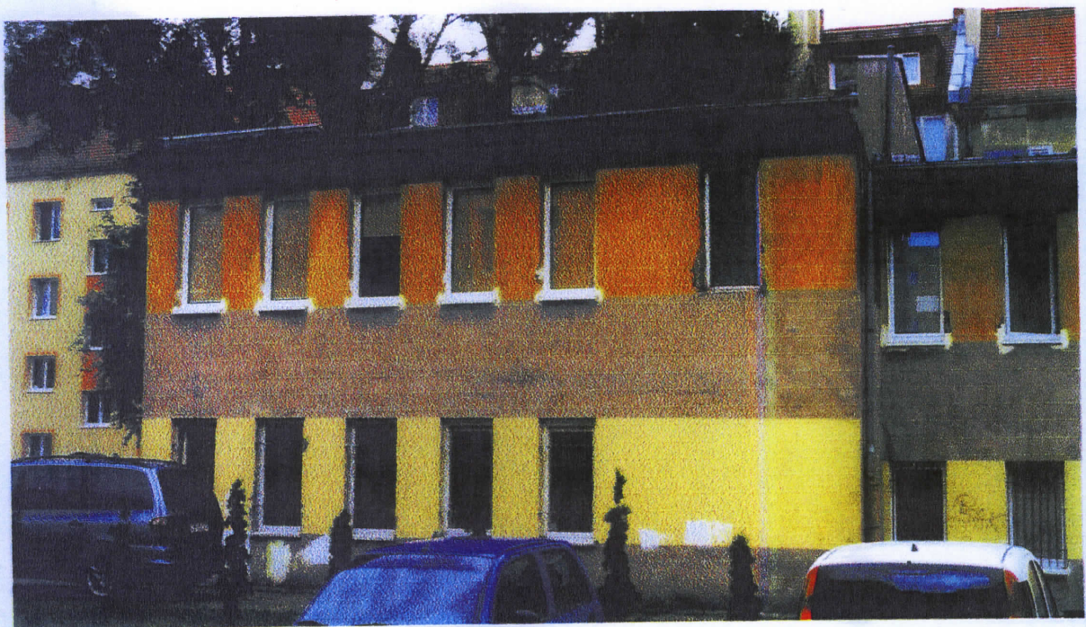
Fot . 3. Ściana D. Fot. Bogdan Rudzionic
