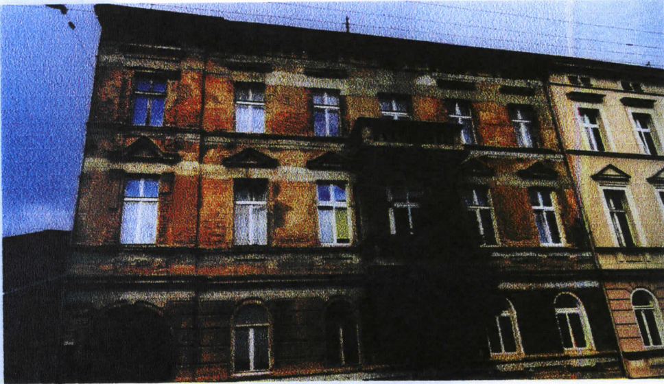
Fot.1.Ściana A. Fot Bogdan Rudzionic
