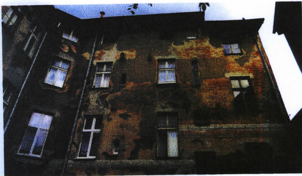
Fot.5.Ściana E. Fot. Bogdan Rudzionic
