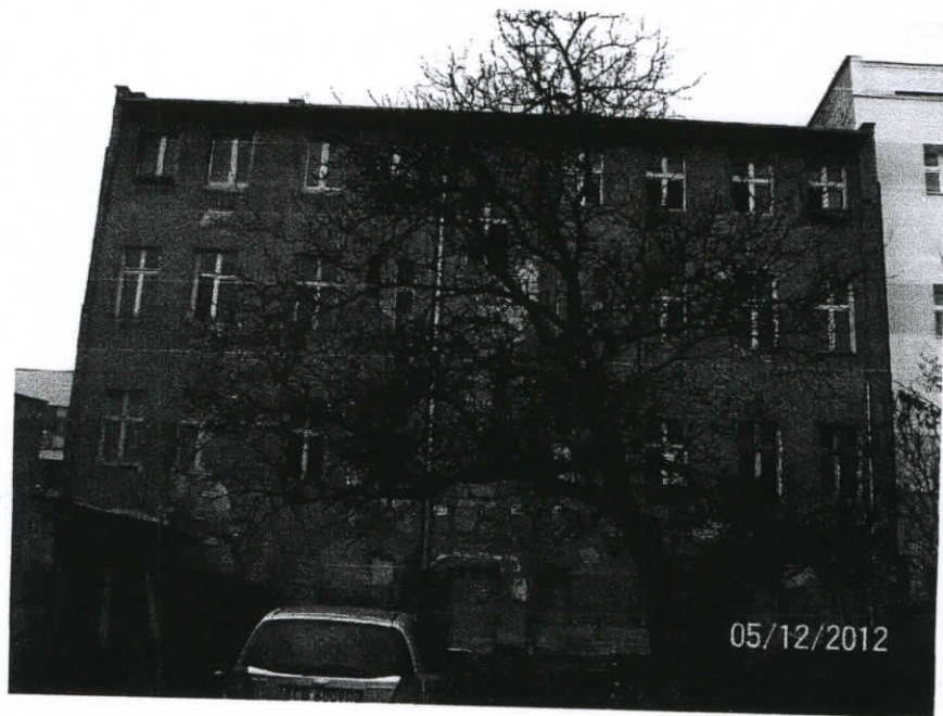
Fot. 2. Elewacja wschodnia (tylna).
