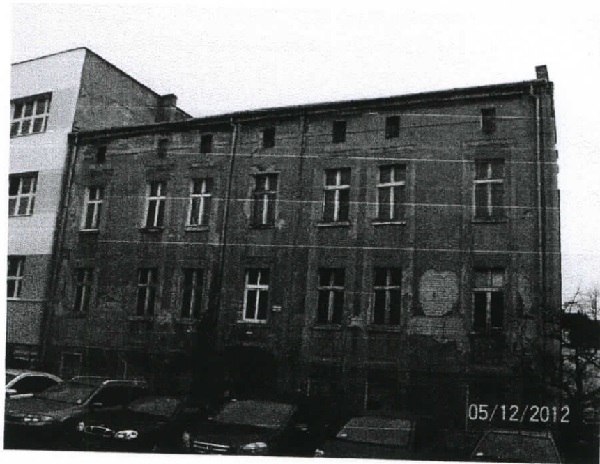
Fot. 1. Elewacja zachodnia (front).
