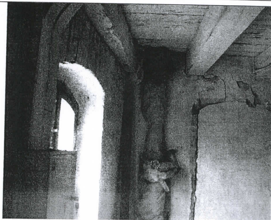
POZIOM III (jak wyżej) WIDOK CAŁEGO NAROŻNIKA PRZY KLATCE SCHODOWEJ
