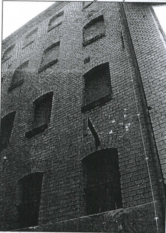
ŚCIANA ZACHODNIA PRZY NAROŻNIKU WYSUNIĘCIE ŚCIANY NA III I IV POZIOMIE SPĘKANIA ŚCIAN, PASKI SZKLANE
