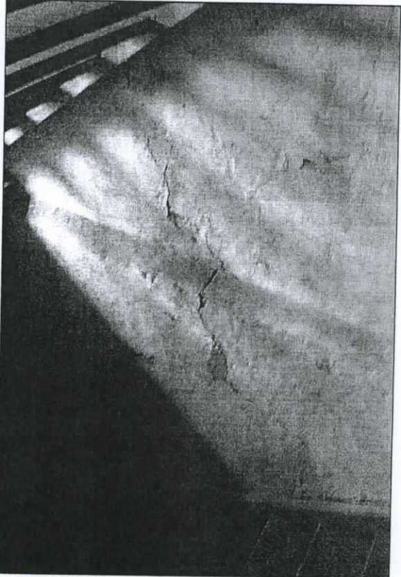
WIDOK PĘKNIĘĆ I ODSPOJEŃ ŚCIANY ZACHODNIEJ WIDOK Z PODŁOGI III POZIOMU WIDAĆ GÓRA SCHODY NA IV POZIOM
