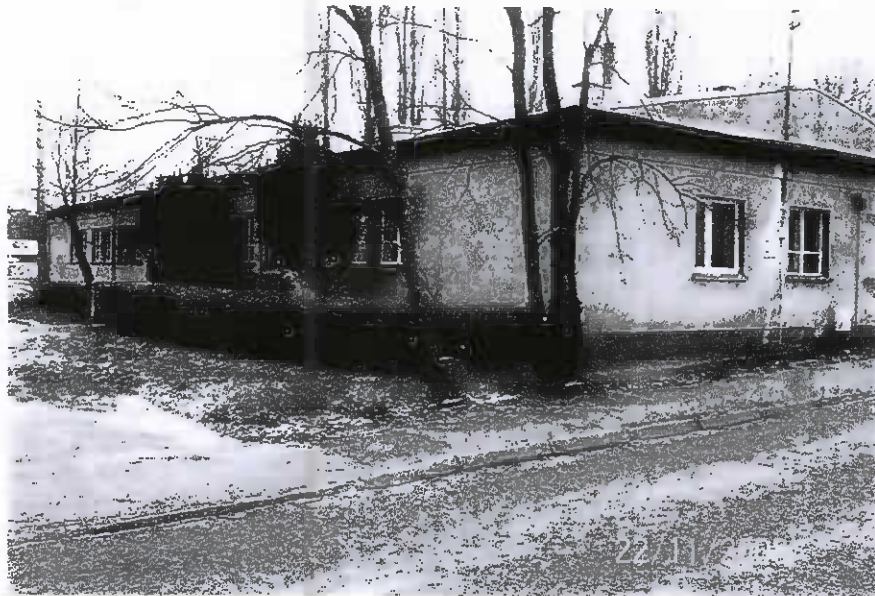
Fot. 1. Widok budynku od strony północno-zachodniej.
