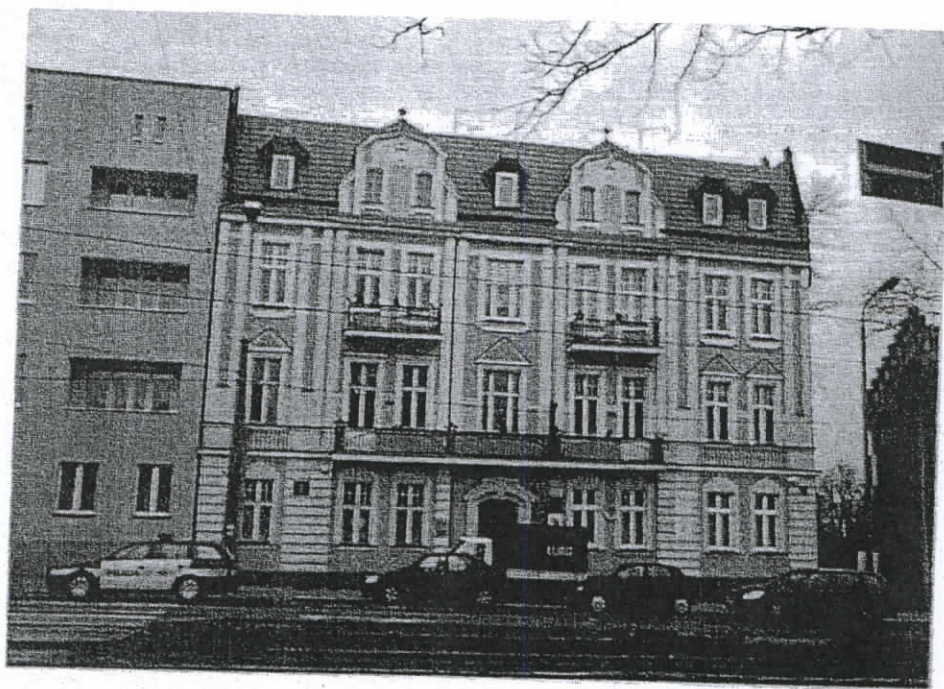
NR 1 ELEWACJA FRONTOWA
