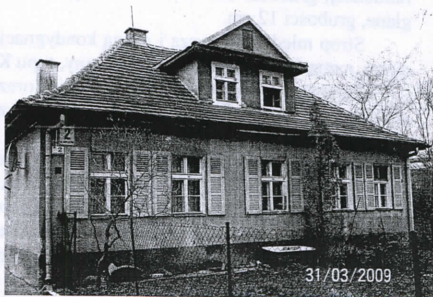
Fot. 1. Widok budynku od strony wschodniej.
