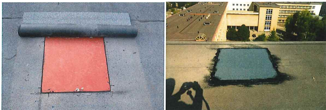
Zamknięcie otworu blachą stalową oraz uzupełnienie papy termozgrzewalnej
