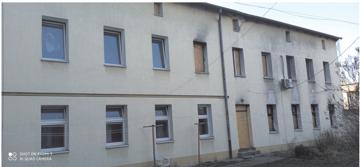
Ściana podłużna frontowa
