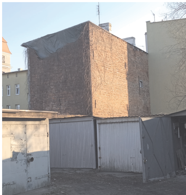
Ściana podłużna tylna i ściana szczytowa
