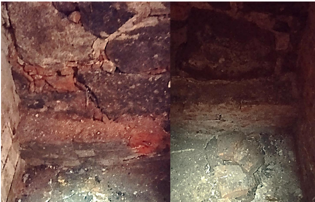
Fot. 4 i 5. Ściana fundamentowa i posadzka w strefach wykonanych odkrywek Grodzka 4 (4.10.2021).
