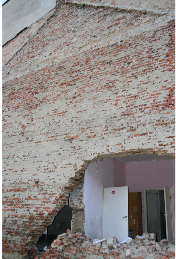
Rys.4,5 - Lewa część wytworzonego w wyniku awarii łuku wraz z widoczną odspojoną ścianą wewnętrzną działową nośną.
