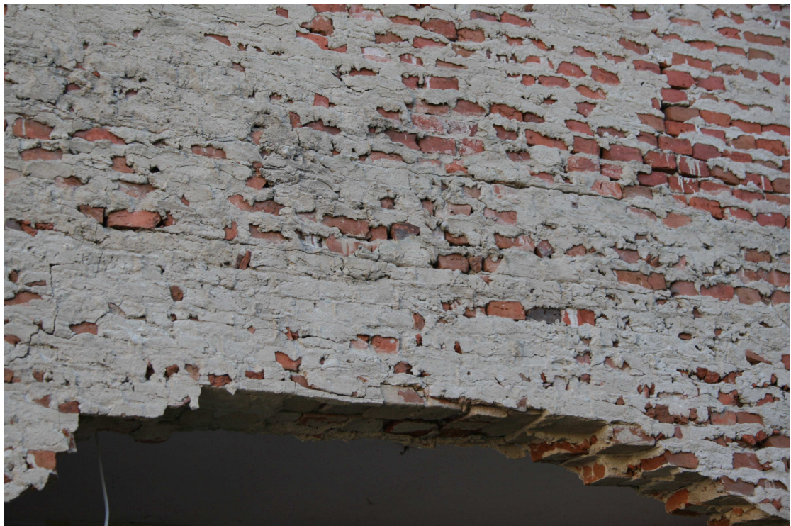
Rys.7 – „klucz” powstałego sklepienia.
