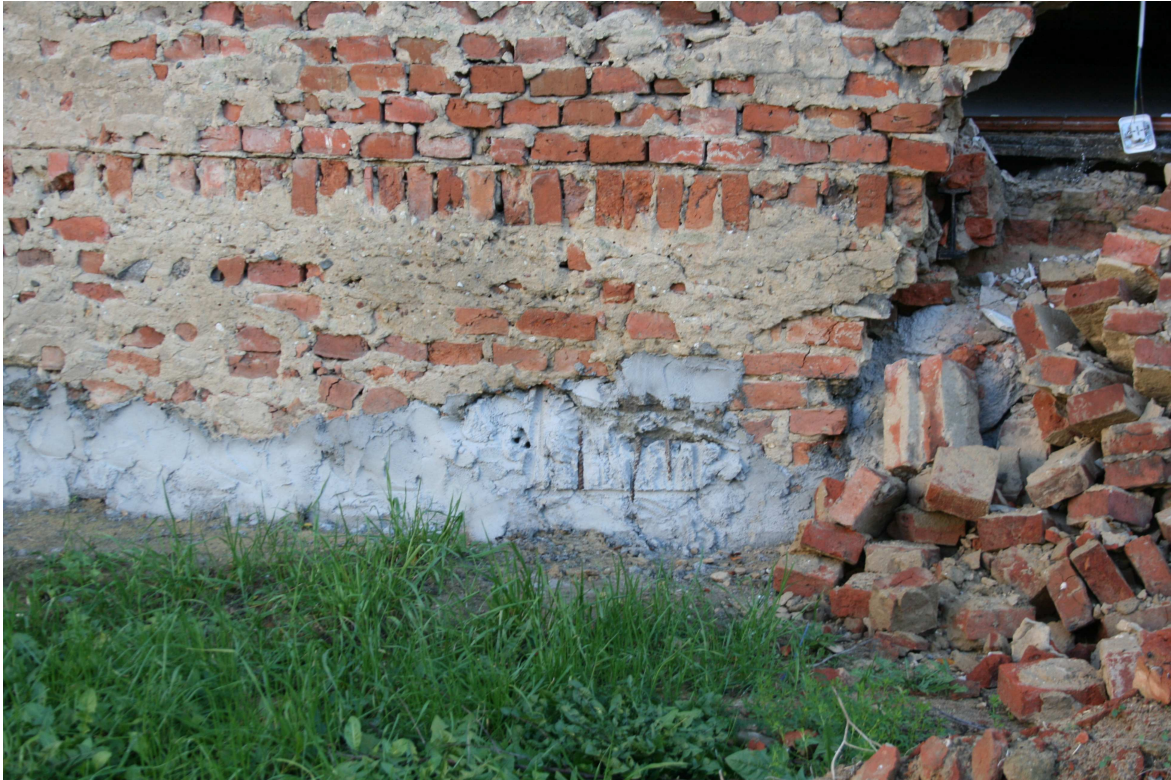
Rys.10 – Początek sklepienia – widok z lewej strony.
