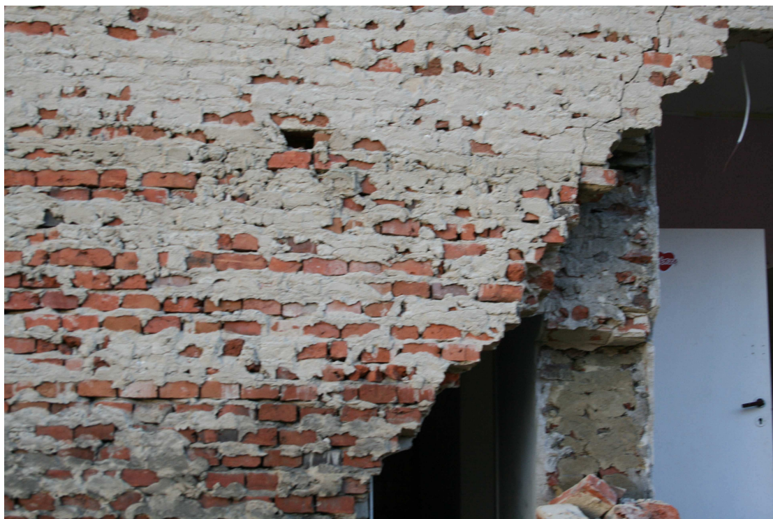
Rys.9 - Powstałe sklepienie – widok z lewej strony z widoczną odspojoną ścianą wewnętrzną działową nośną.
