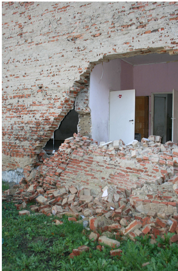
Rys.4,5 - Lewa część wytworzonego w wyniku awarii łuku wraz z widoczną odspojoną ścianą wewnętrzną działową nośną.
