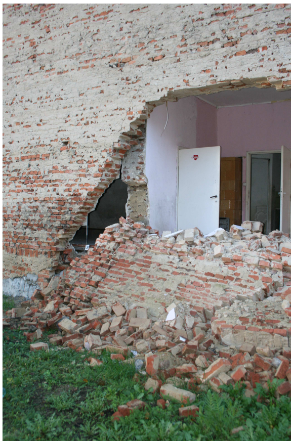
Rys.6,7 - Lewa część wytworzonego w wyniku awarii łuku wraz z widoczną odspojoną ścianą działową nośną.
