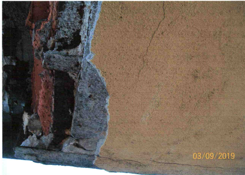
Fot.7. Dobrze zachowane fragmenty konstrukcji wsporczej dla skrajnych cegieł.
