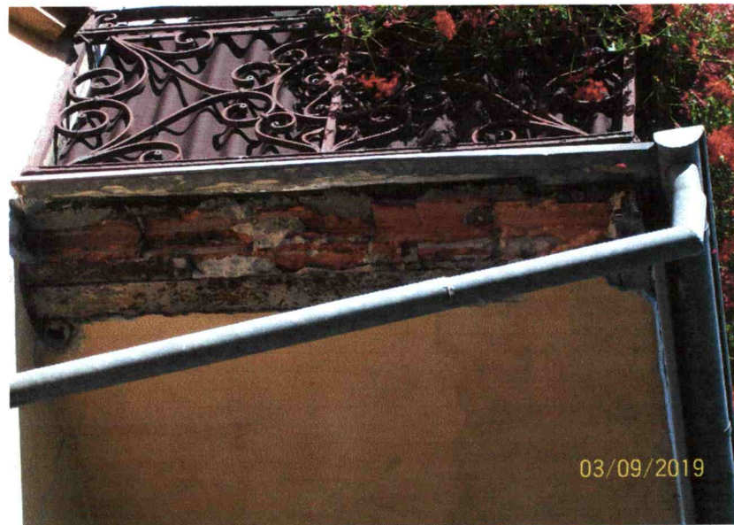
Fot.2. Przekrój płyty balkonowej.
