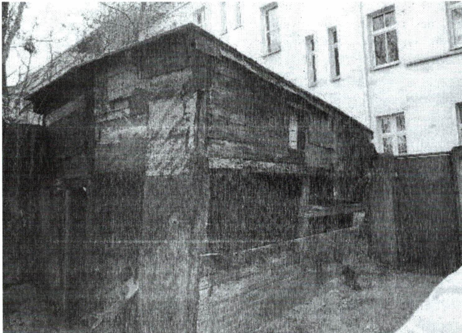
fot. nr 1 Widok ogólny budynku przewidzianego do rozbiórki .
