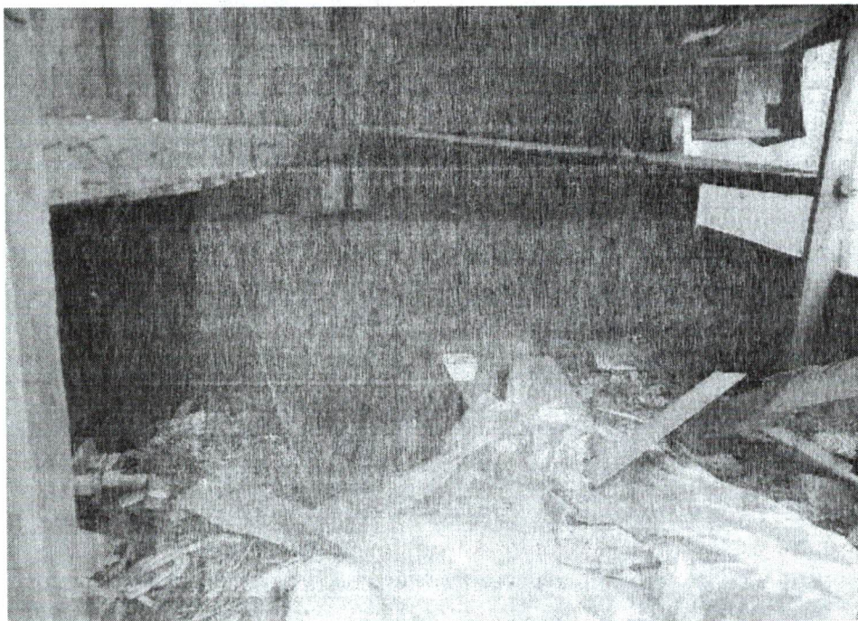
fot. nr 2 Widok wnętrza budynku przewidzianego do rozbiórki.
