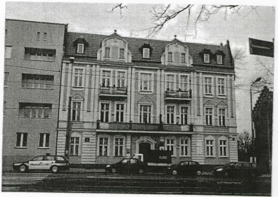
NR 1 ELEWACJA FRONTOWA
