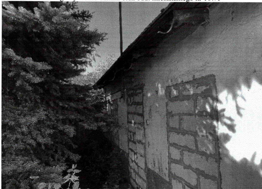
fot. nr 2 Front bud. mieszkalnego nr 107/1 – zamurowane otwory, ubytki blacharki.
