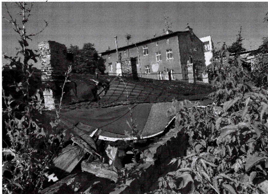
fot. nr 4 Budynek nr 107:2 – dach w około połowie obiektu zawalony do wnętrza budynku.
