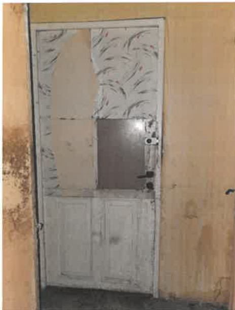
Fot. 1 Korytarz– widok drzwi wejściowych
