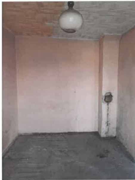
Fot. 10 Pokój – widok ogólny pomieszczenia
