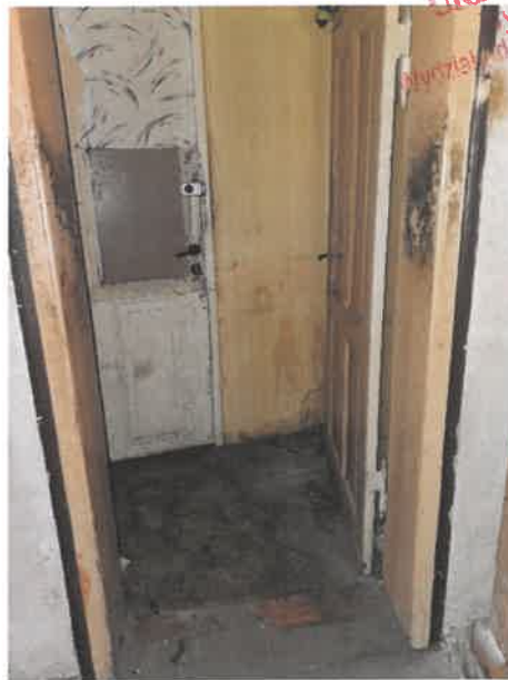
Fot. 2 Korytarz– widok pomieszczenia
