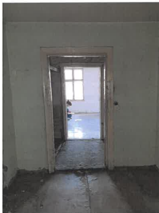
Fot. 5 Pokój – widok przejścia do komunikacji
