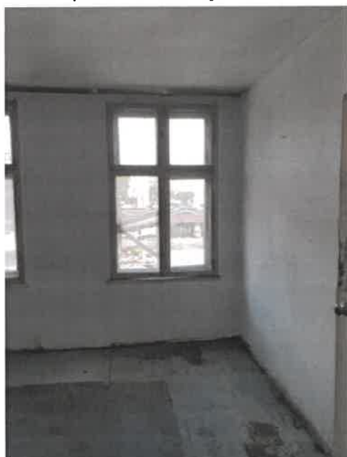
Fot. 8 Pokój – widok stolarki okiennej
