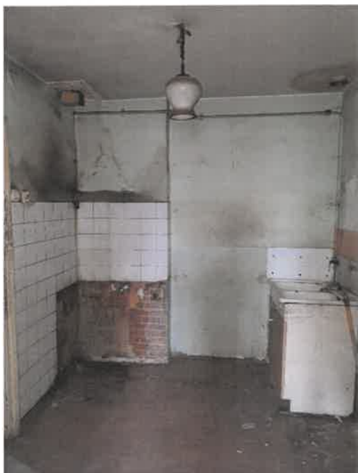
Fot. 4 Pokój – widok ogólny pomieszczenia
