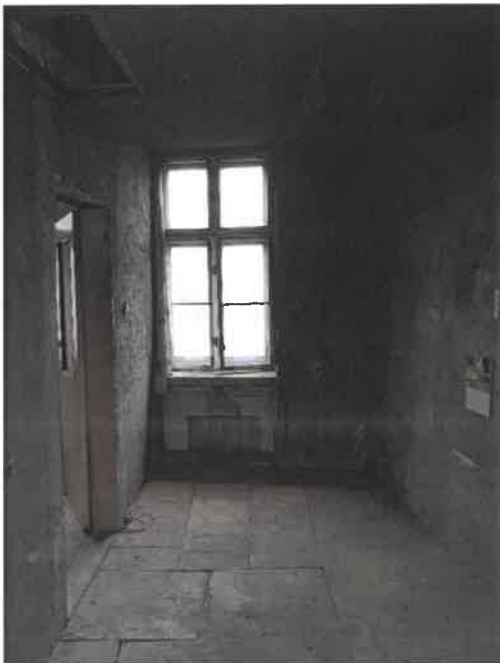
Fot. 3 Pokój – widok stolarki okiennej
