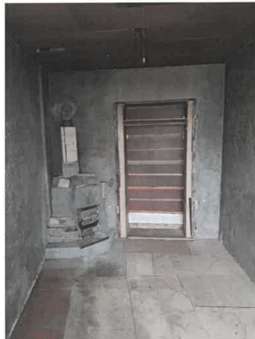
Fot. 4 Pokój – widok ogólny pomieszczenia
