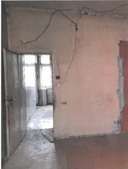
Fot. 5 Pokój – widok ogólny pomieszczenia
