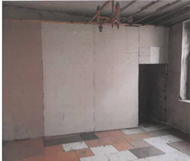
Fot. 6 Pokój – widok ścianki z płyt g-k
