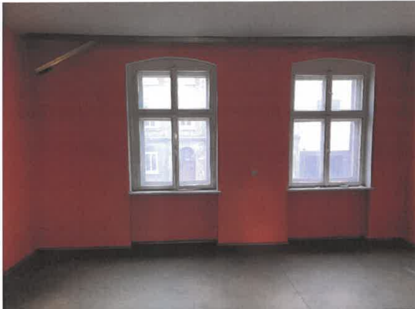
Fot. 5 Pokój 2 – widok stolarki okiennej
