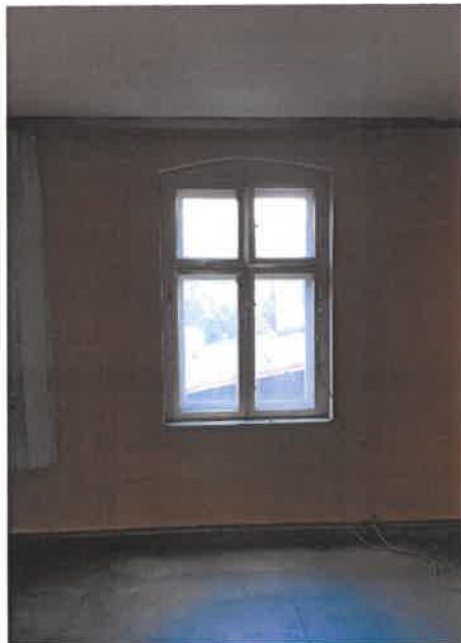
Fot. 3 Pokój – widok stolarki okiennej
