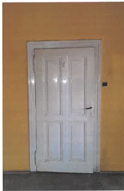
Fot. 4 Pokój – widok ściany działowej z płyty g-k
