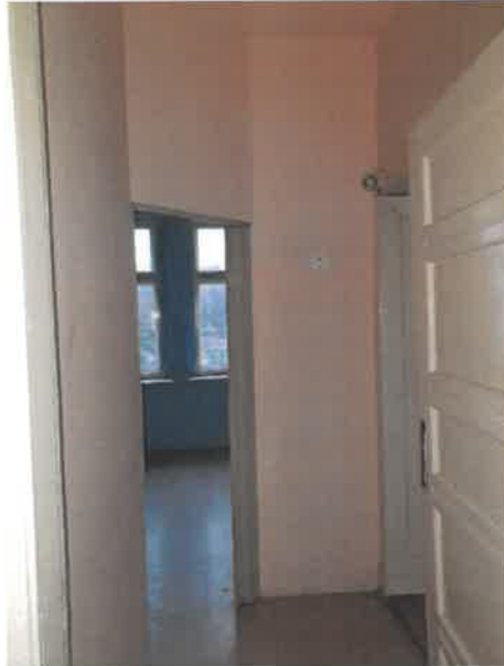
Fot. 1 Korytarz– ogólny widok pomieszczenia
