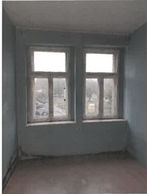
Fot. 6 Pokój – widok stolarki okiennej
