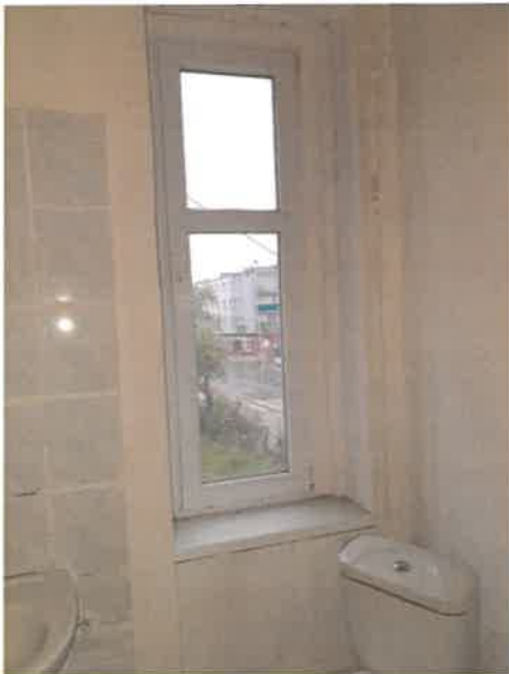
Fot. 4 łazienka – widok stolarki okiennej
