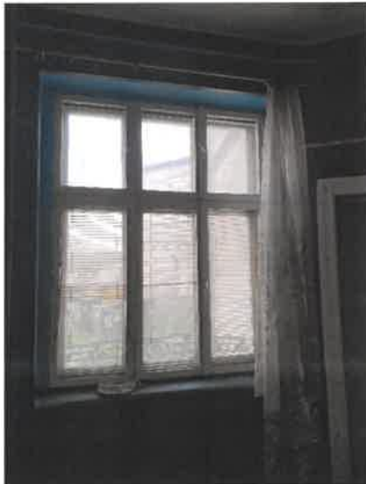
Fot. 3 Pokój – widok stolarki okiennej
