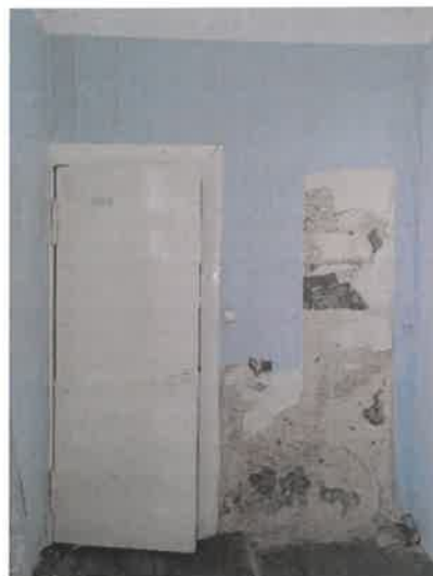
Fot. 4 Pokój – widok ogólny pomieszczenia
