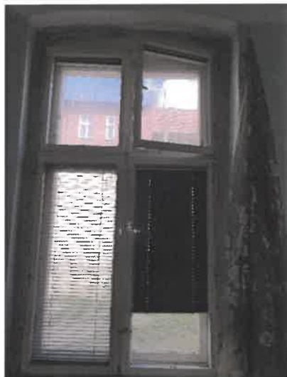
Fot. 3 Pokój – widok stolarki okiennej
