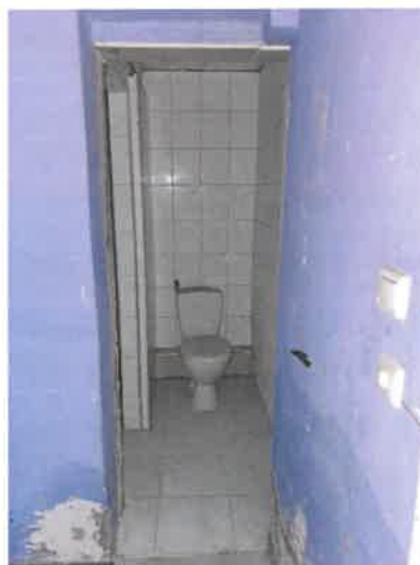
Fot. 8 Pokój – widok pomieszczenia wc
