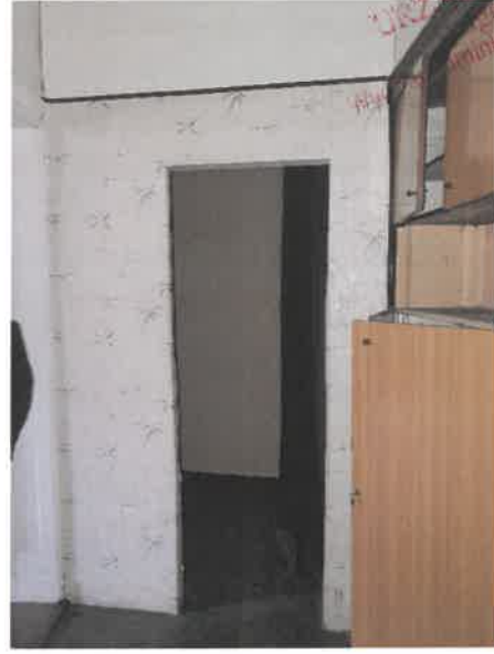
Fot. 2 Pomieszczenie gosp.– widok przejścia z przedsiónek
