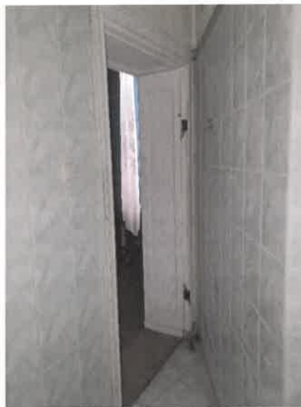
Fot. 10 Kuchnia – widok przejścia do pokoju
