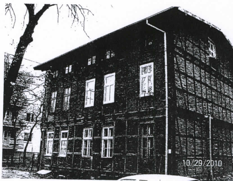
Fot. 1. Elewacja północna budynku.
