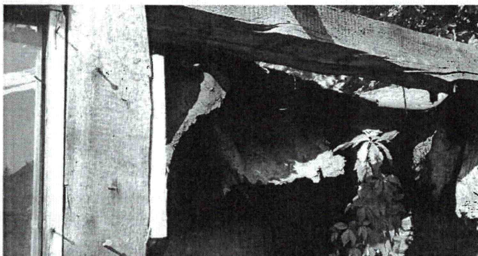
Fot. 10 Konstrukcja dachu drewnianej dobudówki
