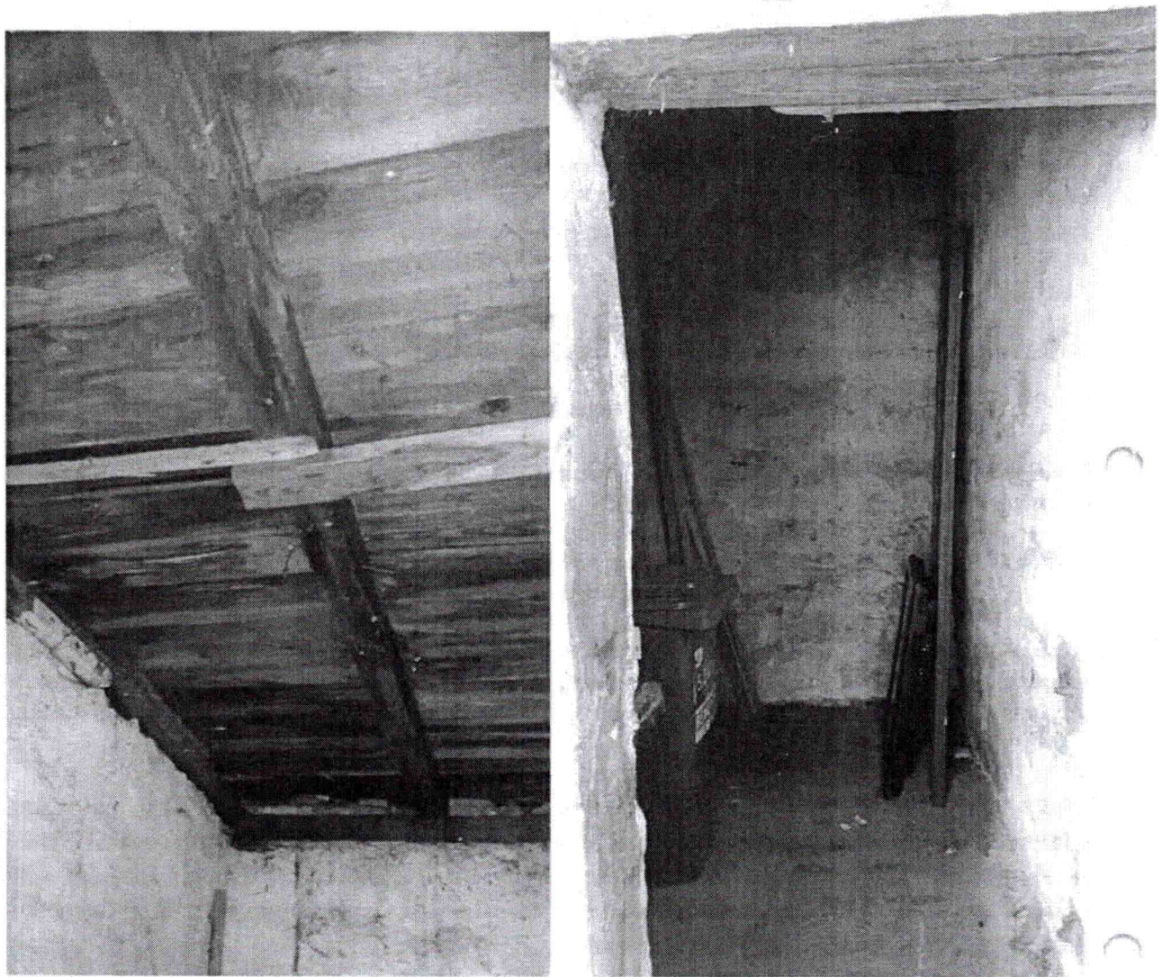
Fot. 2 Widok na poszycie z desek na konstr. drewnianej w komórce budynku gospodarczego
