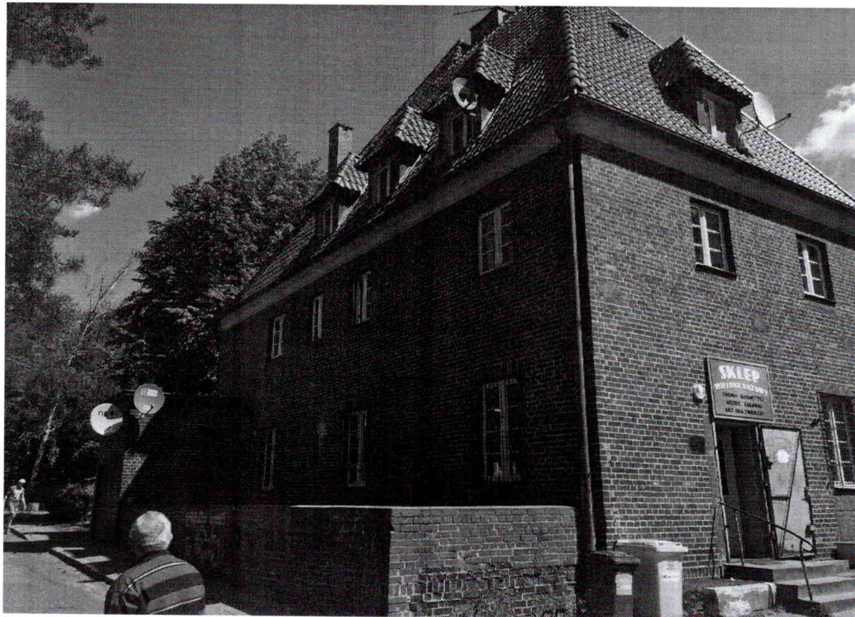
Fot. 3. Elewacja boczna
