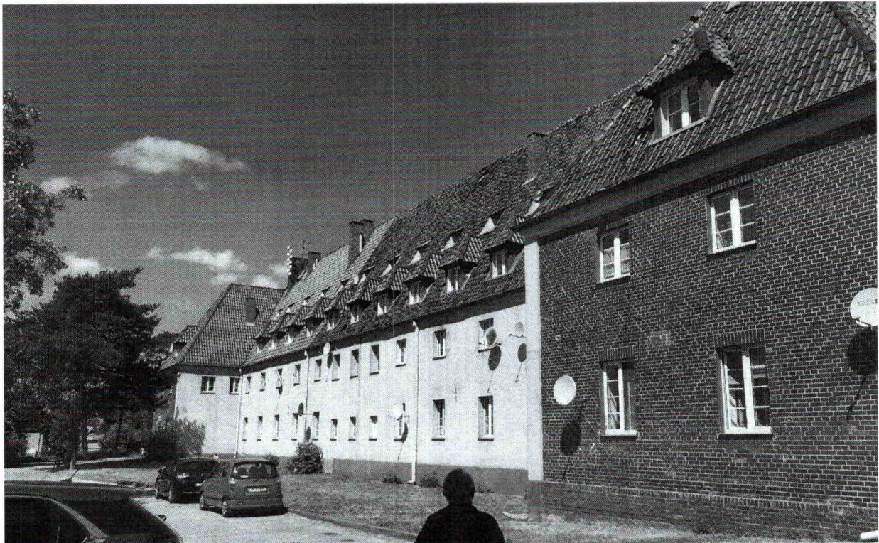
Fot. 2. Elewacja tylna
