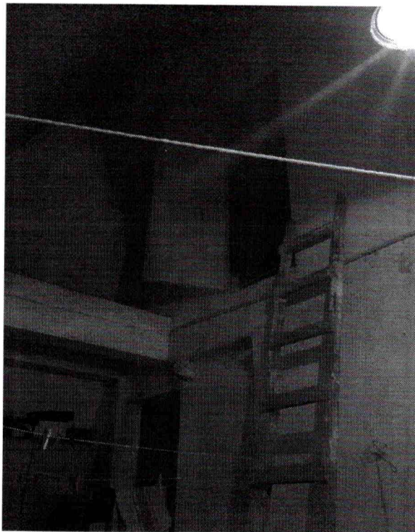
Fot. 5. Wejście na poddasze
