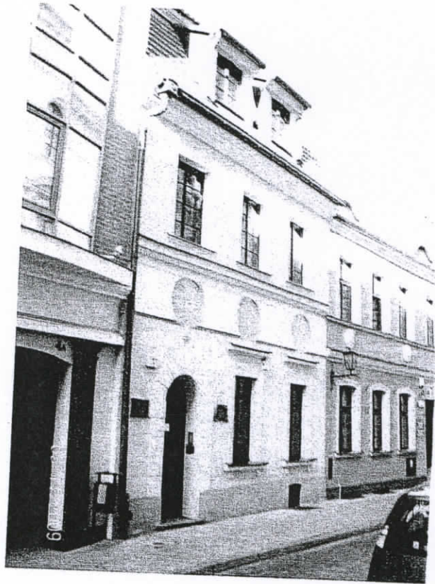
Fot. 1. Wygląd ogólny budynku od strony ulicy Jezuićkiej.
