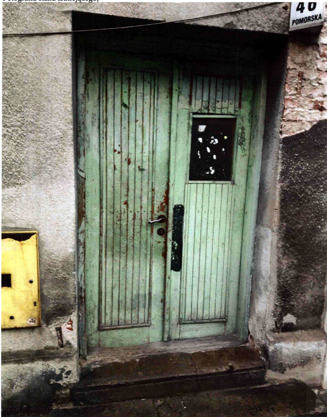
Fotografia stanu istniejącego,
