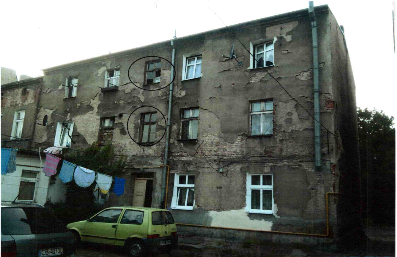
Chelmińska 22 – okna klatka schodowa
