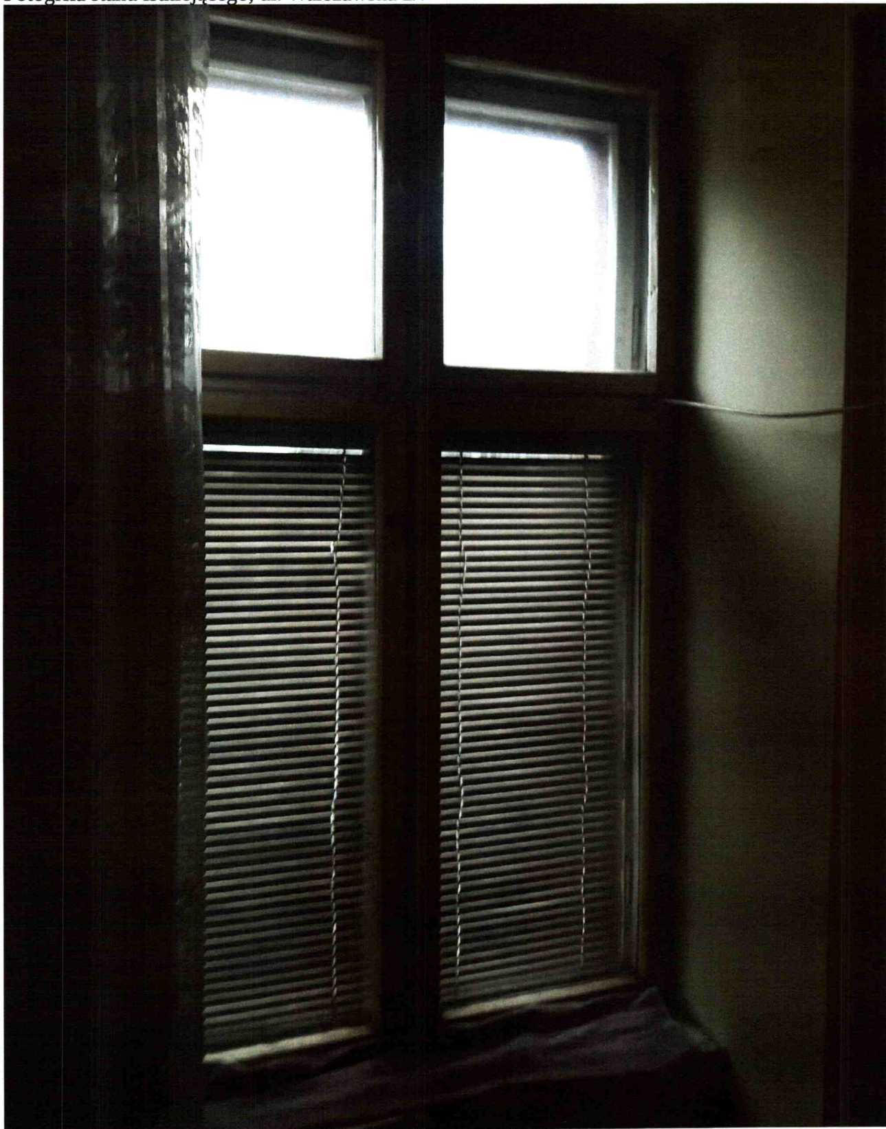
Fotografia stanu istniejącego, ul. Warszawska 2/7
