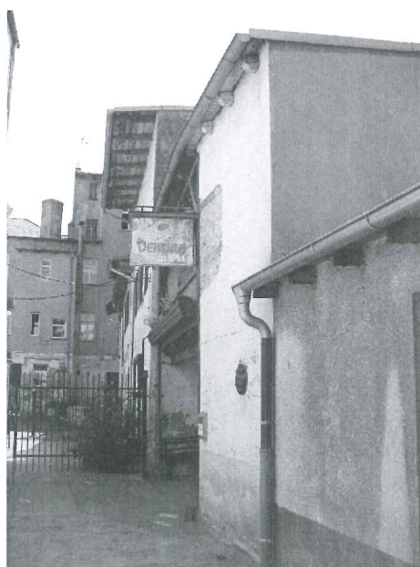
zdj.5. elewacja frontowa i boczna
