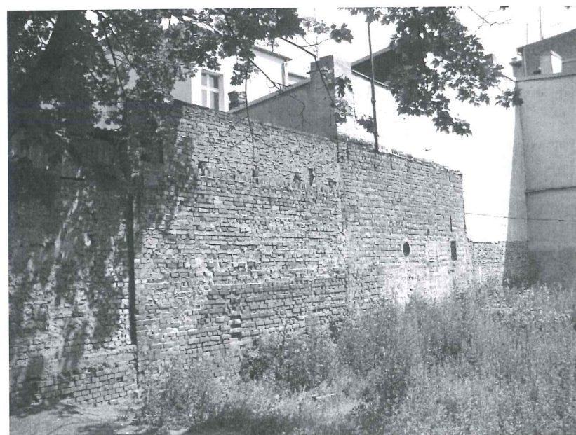
zdj.4. elewacja tylna
