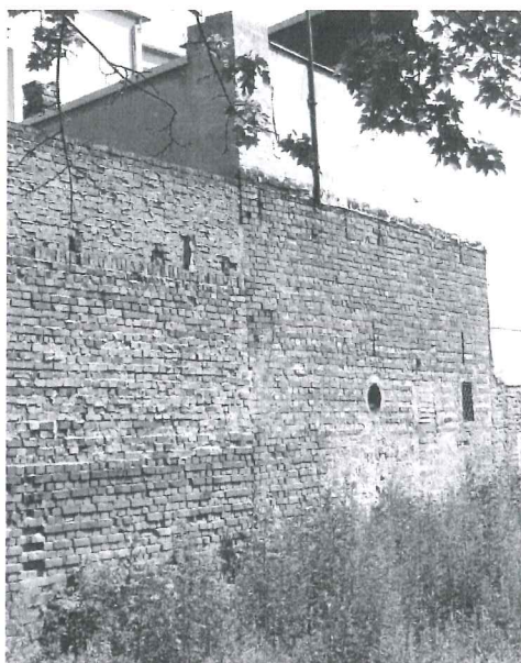
zdj.6. elewacja tylna
