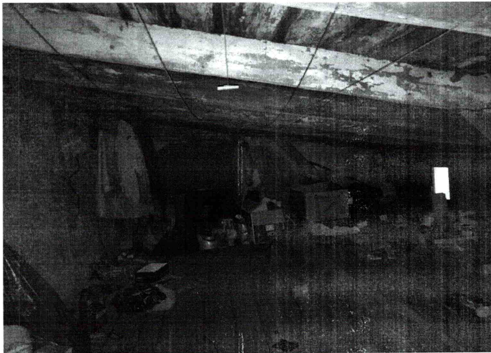
fot. nr 4 Poddasze użytkowe budynku oficyny mieszkalnej.
