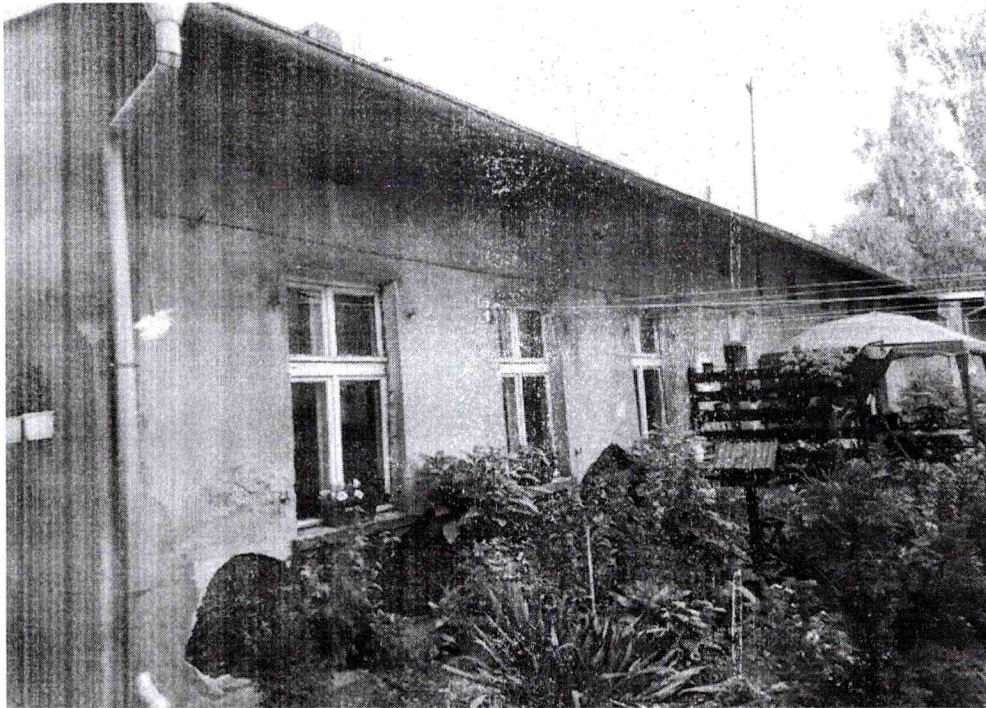
fot. nr 1 Widok ogólny budynku oficyny mieszkalnej przewidzianej do rozbiórki – widoczne uszkodzenia elewacji frontowej.
