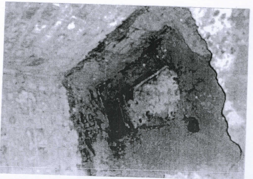
STUDZIENKA I PO WYPOMIOWANIU WODY NR 11
