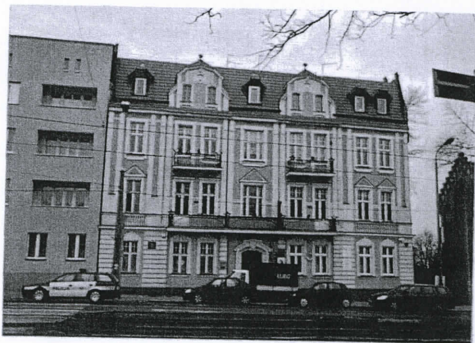
NR 1 ELEWACJA FRONTOWA
