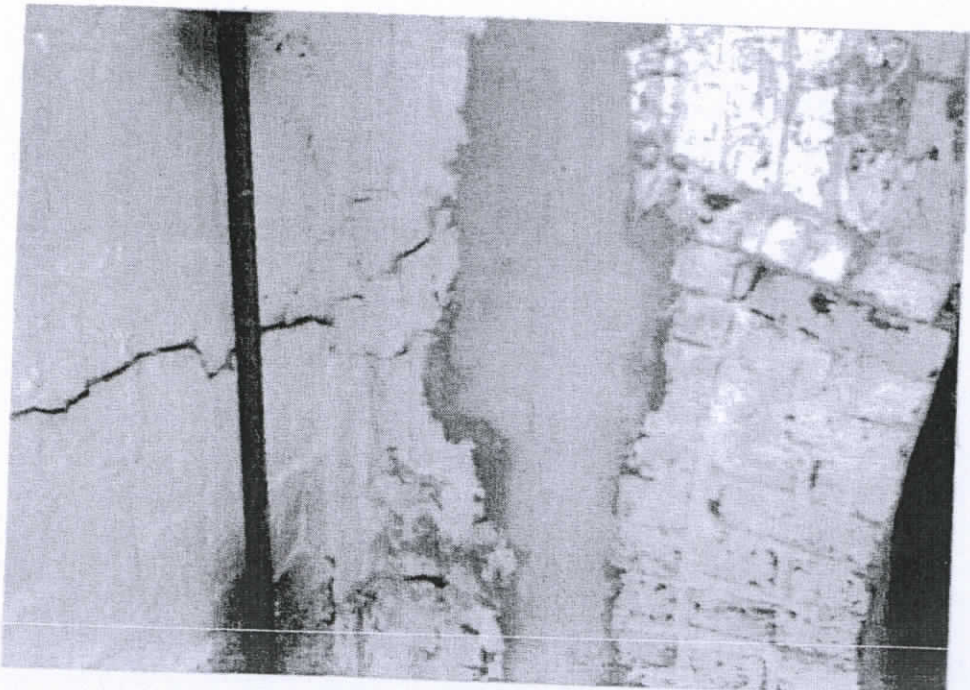
NR 6 PINKNICA - SPĘKANE NADPROŻE I SUFIT
