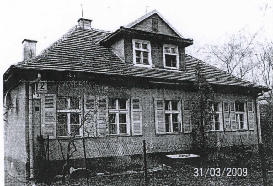
Fot. 1. Widok budynku od strony wschodniej.
