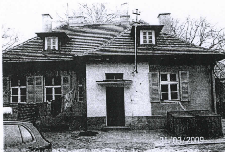
Fot. 2. Elewacja zachodnia.
