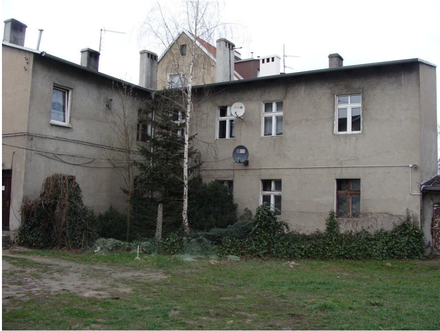
Widok elewacji wschodniej i południowej od strony podwórza.
