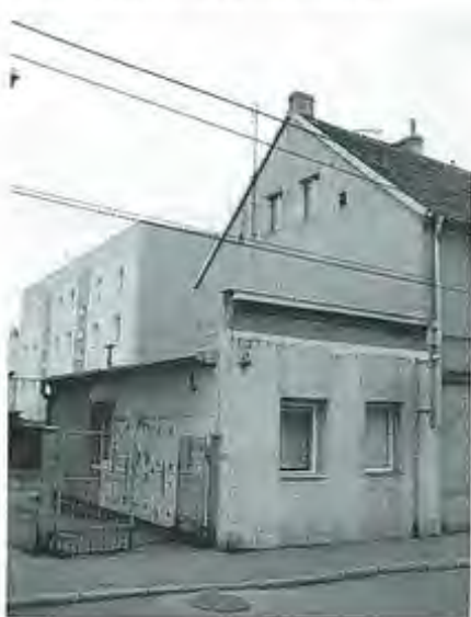
Przybudówka i elewacja północna budynku głównego.
