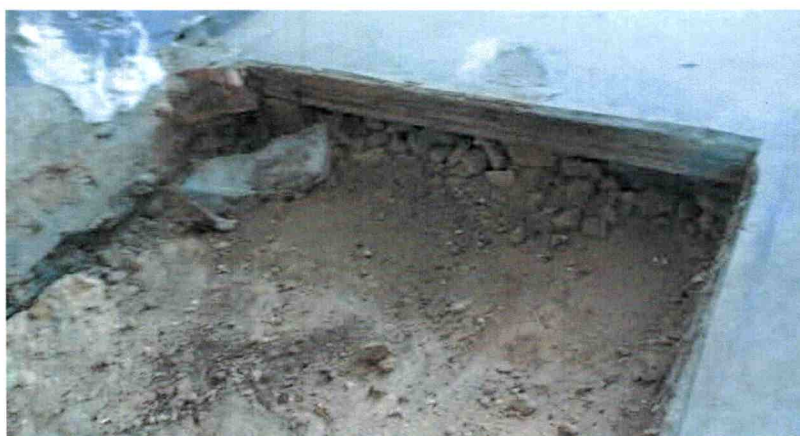
Zdjęcie 32: Pomieszczenie nr 1.03 (ubytek w posadzce po dawniej zlokalizowanym piecu kaflowym)
