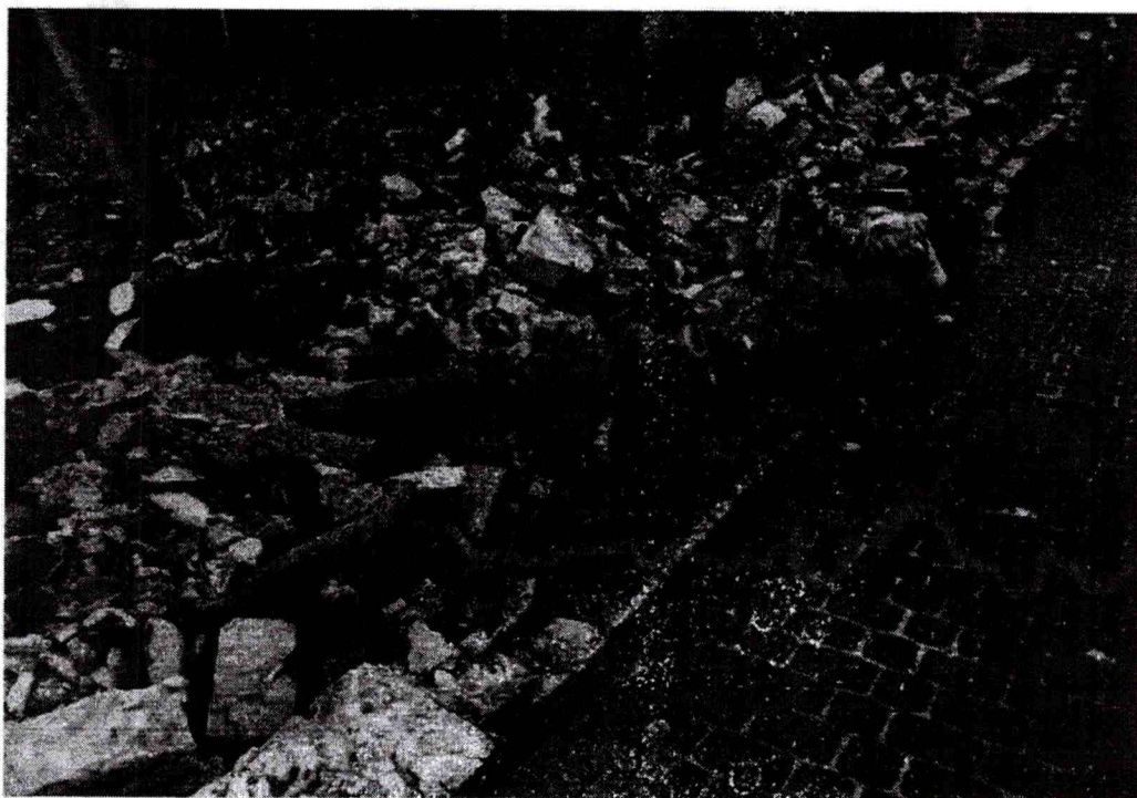
fot. nr 2 Pozostałości ogrodzenia po przewróceniu.
