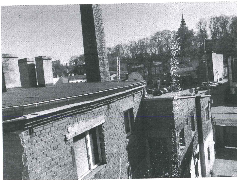
fot. nr 4 Widok ogólny budynku przewidzianego do rozbiórki oraz komina linii produkcyjnej piekarni przewidzianego do rozbiórki – widok z kamienicy frontowej pod adresem Poznańska 23.
