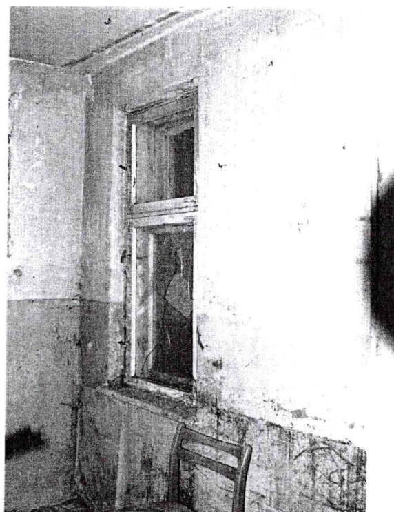
Oficyna przy ul. Chełmińskiej 14 Wnętrze - widok na okno w kuchni
