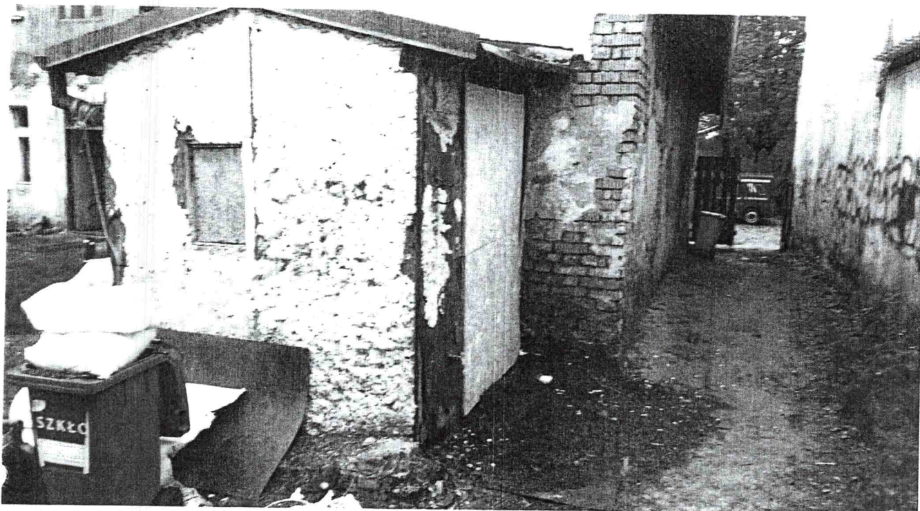
Oficyna przy ul. Chełmińskiej 14 Elewacja podwórzowa Pd-Wsch
