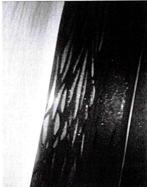
Fot.1,2. Wykraplanie się wody na ścianie na skutek osiągnięcia przez nią punktu rosy.
