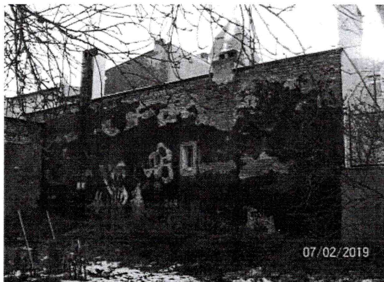
Fot.6. Widok ogólny elewacji północno- wschodniej budynku.
