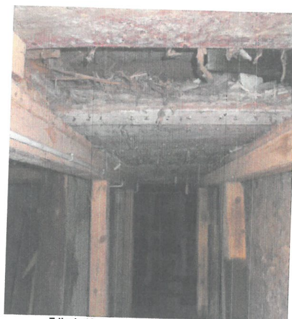
Zdjęcie 18: Piwnica – uszkodzenie stropu
