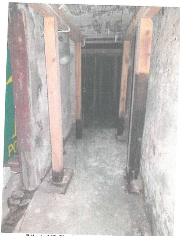
Zdjęcie 145: Piwnica – uszkodzenie stropu
