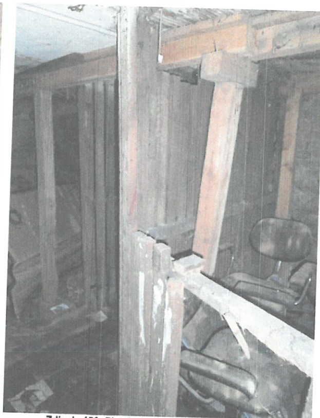
Zdjęcie 156: Piwnica – uszkodzenie stropu
