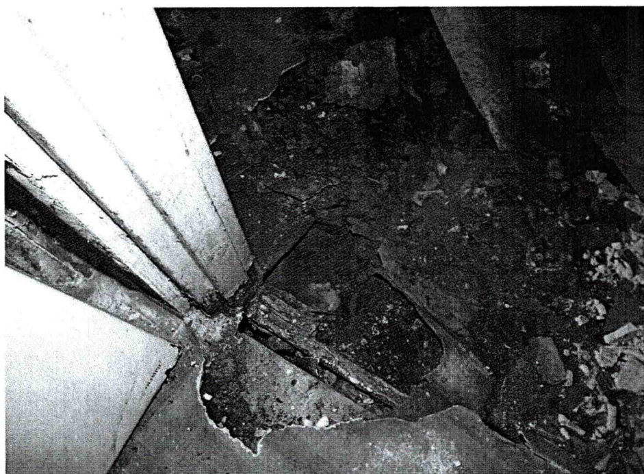
Zdjęcie nr 4 Stan posadzki i podkładów w pomieszczeniu kuchni i łazienki .
