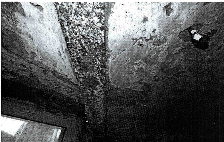
Poniżej: Stan dźwigara dwuteowego ceglanego stropu łukowego.
