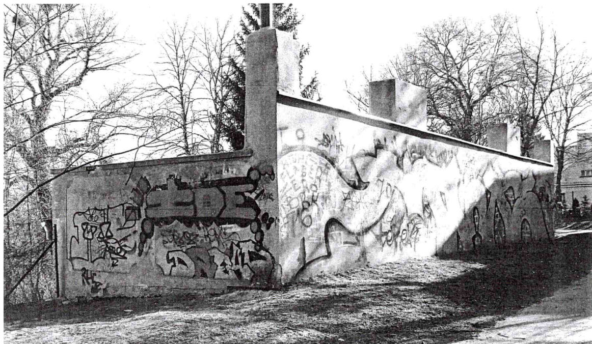
Fot. 3. Widok ściany zachodniej i południowej
