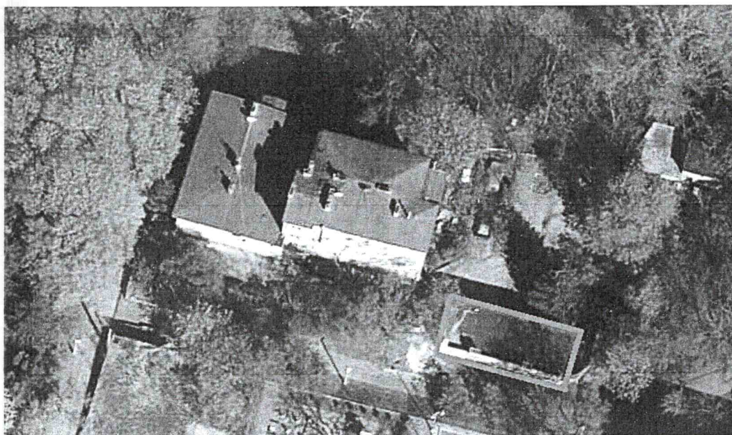
Fot. 1. Widok budynku na którym prowadzono obserwacje
