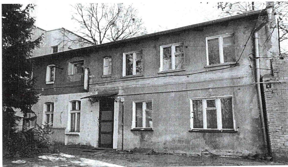
Fot. 2. Widok ściany północnej – frontowej.
