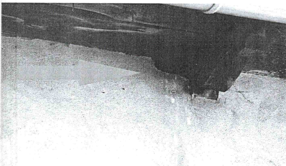
Fot. 6. Oznaczone miejsce lęgowe ptaków pod drewnianą obróbką dachu z widocznymi śladami odchodów.
