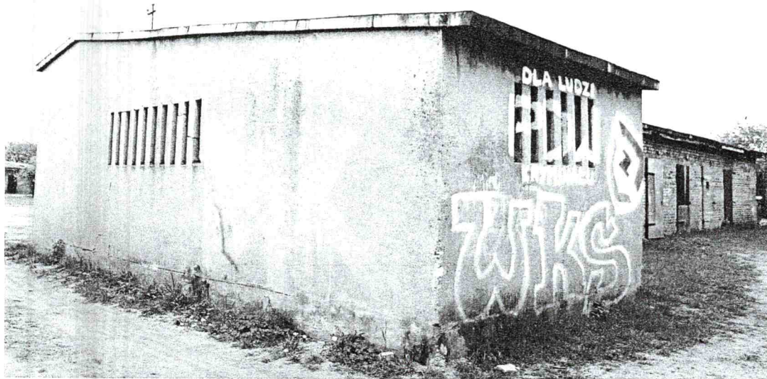
Fot. 5. Widok ściany wschodniej obserwowanego budynku.
