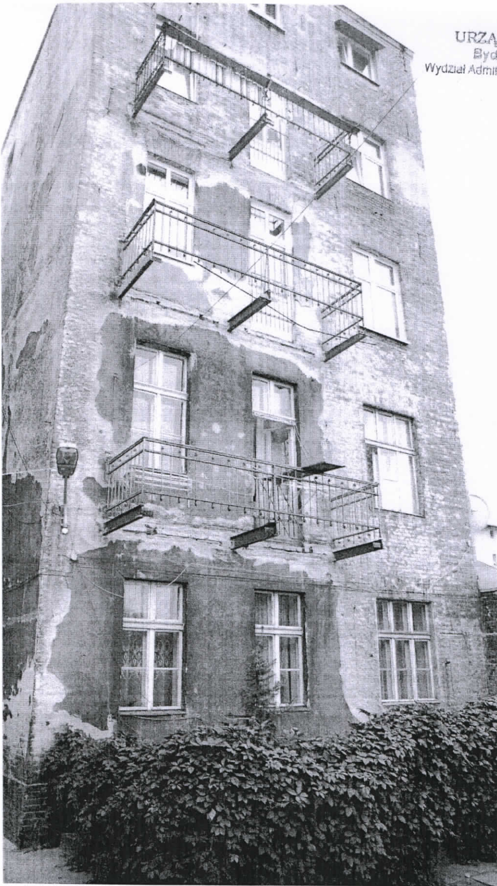
Ściana oficyny z elementami balkonów. Stan istniejący. Ul. Gdańska 79 Bydgoszcz
