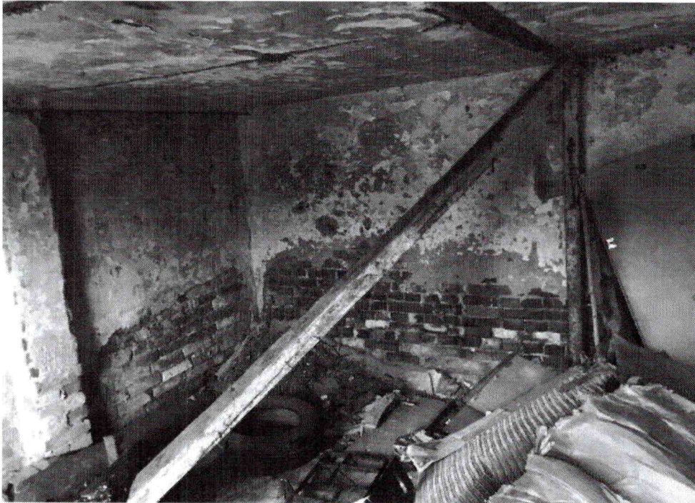
fot. nr 3 Wnętrze budynków 95/2:2 oraz 95/2:3.
